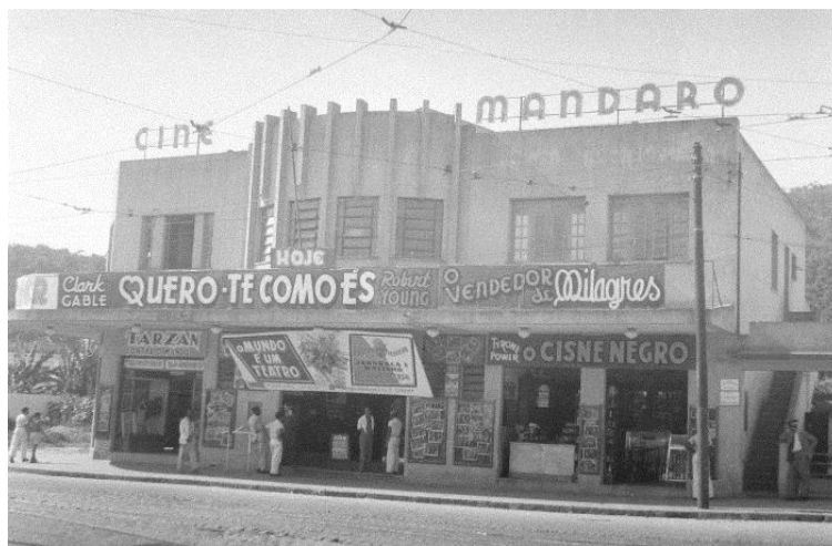
Cinema Mandaro, inaugurado em dezembro de 1940 no bairro de Santa Rosa, em Niterói. 10
